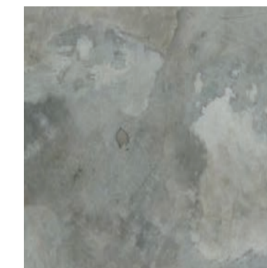
Interiør overflater pigmentert og pusset betong
