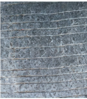
Grunnbelegning, revet betong
